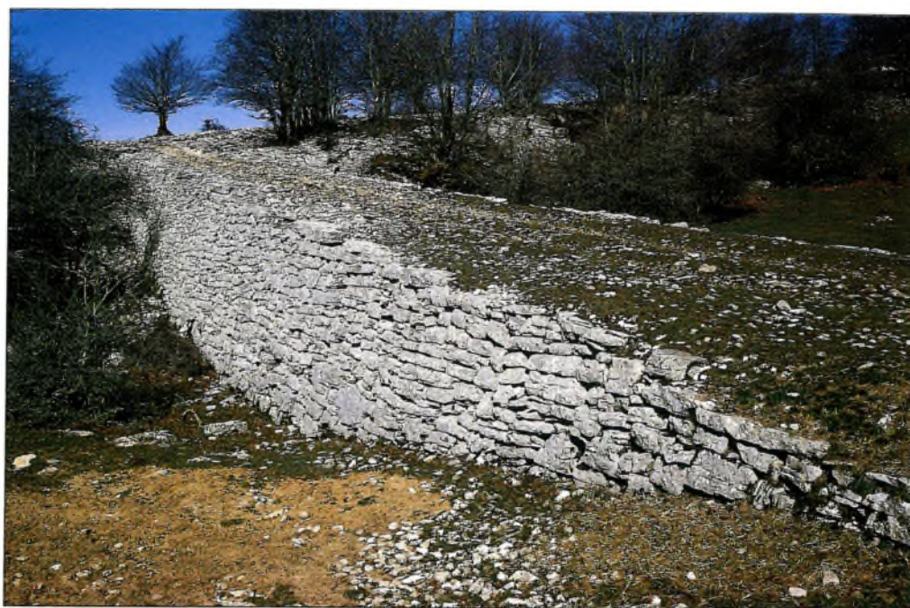
Figura 103.- Calzada de Urbasa, de la venta de Zumbel a Bacaicoa. En algunos puntos el desnivel se salva con potentes muros. Foto M. Sarobe.
