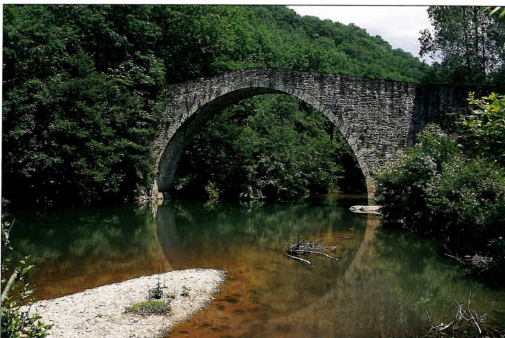
Figura 88.- Puente de Reparacea sobre el río Bidasoa después de una limpieza, podemos contemplar la perfecta ejecución del arco de medio punto, que reflejado en el agua, se convierte en perfecta circunferencia. Foto V. M. Sarobe.
