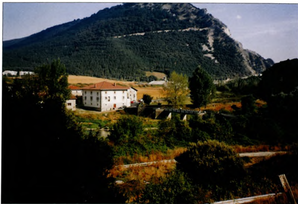
Figura 126.- Puente de Osquía. Foto I. Castiella
